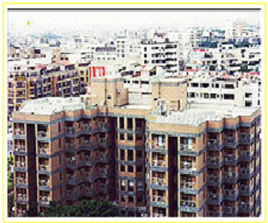
國立成功大學-勝二舍 施工日-83年4月 完工日-83年6月
