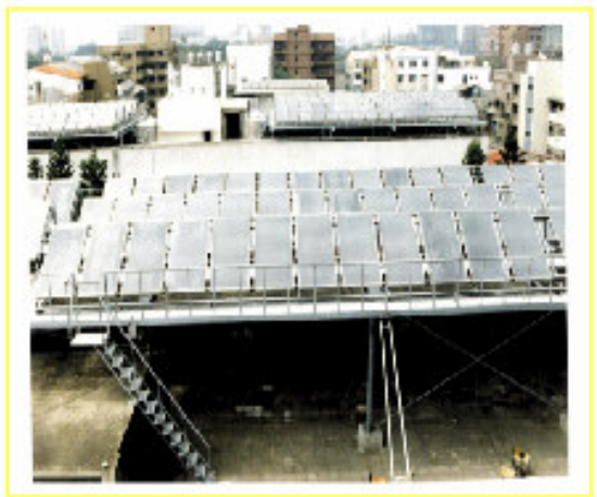
國立成功大學-敬業校區 施工日-83年4月 完工日-83年6月
