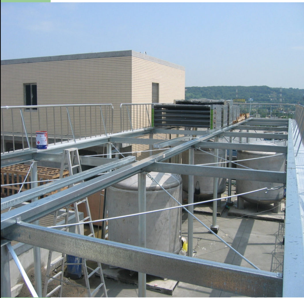
安裝高架結構現場實景
