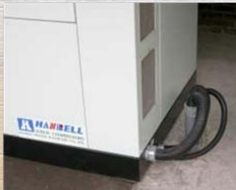
電源線連結 - 防 潮、隔離
