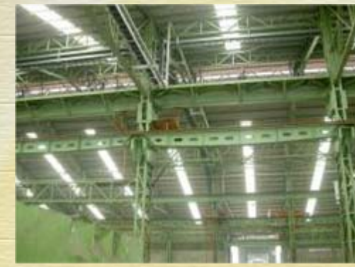
環狀管路改善 - 雙進氣管路
