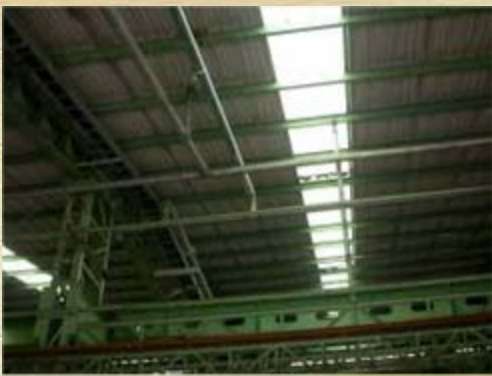
管徑加大 - 壓降 控制在 < 0.1K
