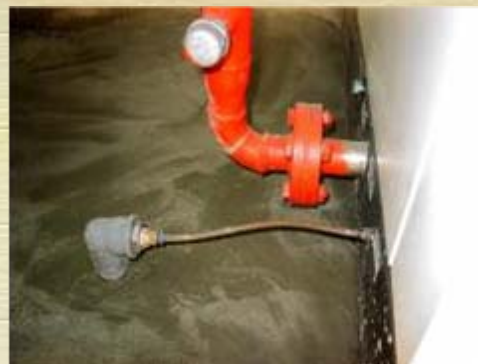
空氣管連結 - 歧 管與卻水
